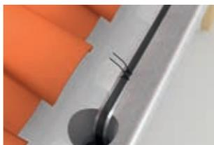
**Kantenschutz** am Übergang von Dachrinne in Fallrohr.
